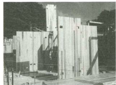
CLT施工現場
