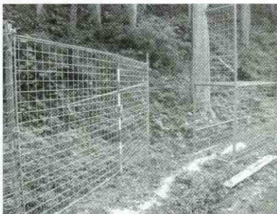
▲シカ捕獲誘導柵と捕獲檻の設置
